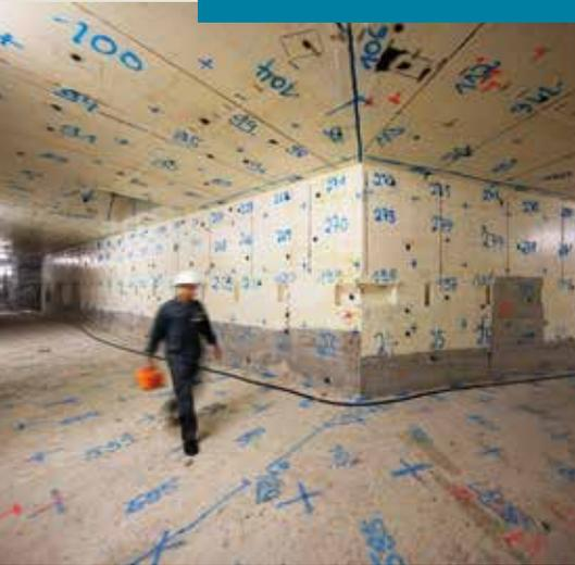
Damit von den rückzubauenden Gebäuden keine Gefährdung aufgrund von radioaktiven Stoffen mehr ausgeht, müssen auch kleinste Spuren beseitigt werden. Jeder Quadratmeter Oberfläche wird erfasst und ausgemessen, ggfs. muss weitere Oberfläche abgetragen werden. Werden Kontaminationen an unzugänglichen Stellen gefunden, müssen Zugän-
