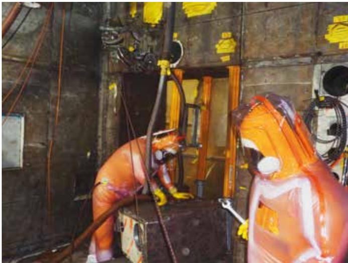
Manueller Rückbau in den Heißen Zellen.
